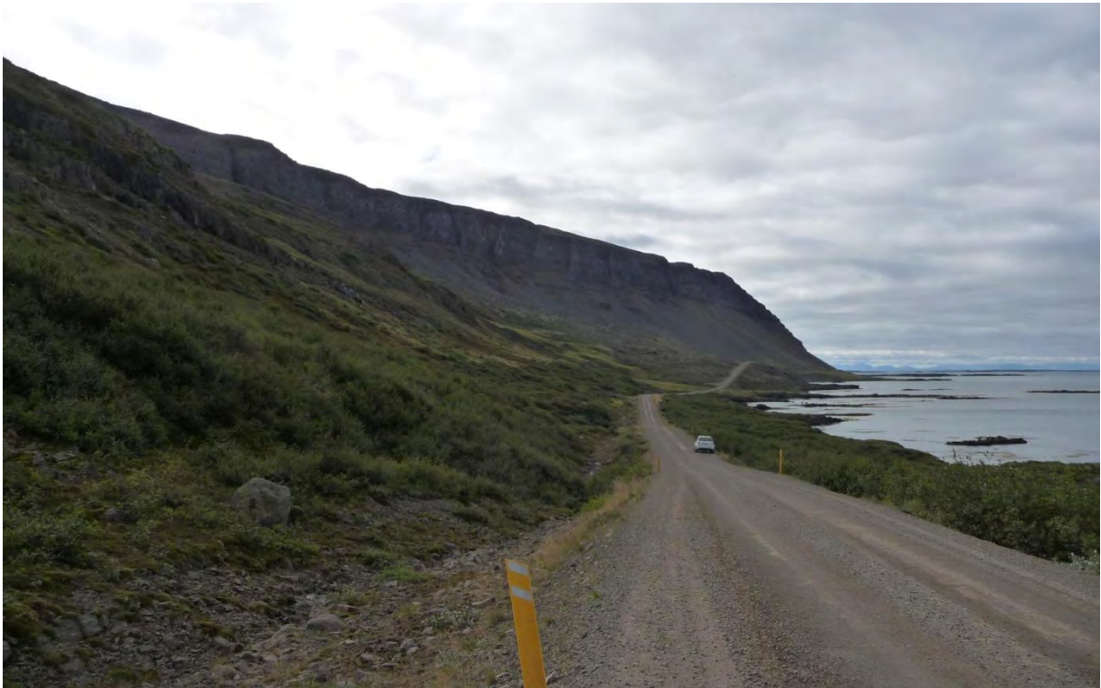
Mynd 2. Núverandi vegur í Kjálkafirði, horft út fjörðinn austanverðan (svæði VII og VIII) í átt að Litlaneshrauni og Litlanesi. Vegurinn fylgir vel hæðum landslagsins.
